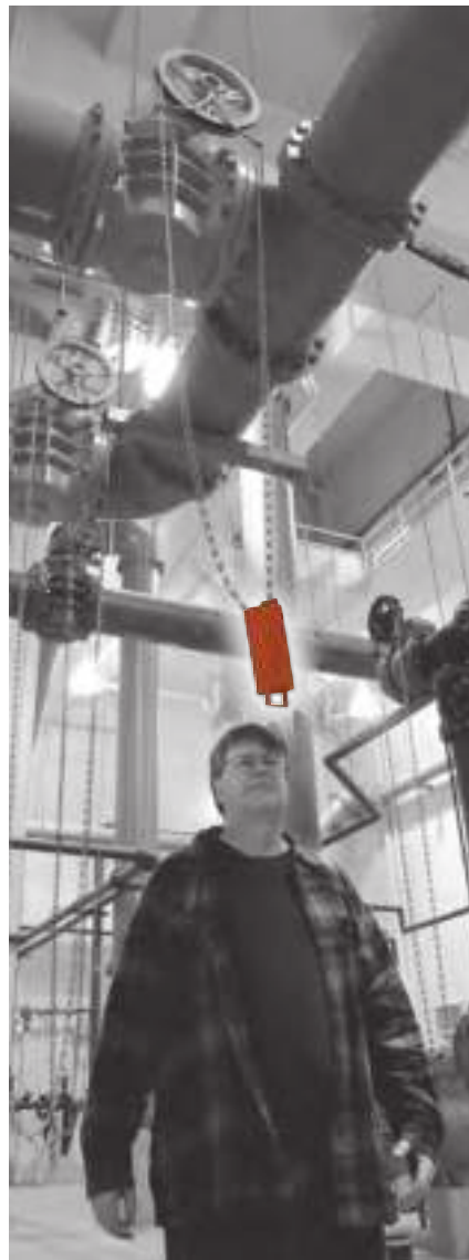
Die Kette im SCHUTZGEHÄUSE über den Köpfen der Mitarbeiter.
